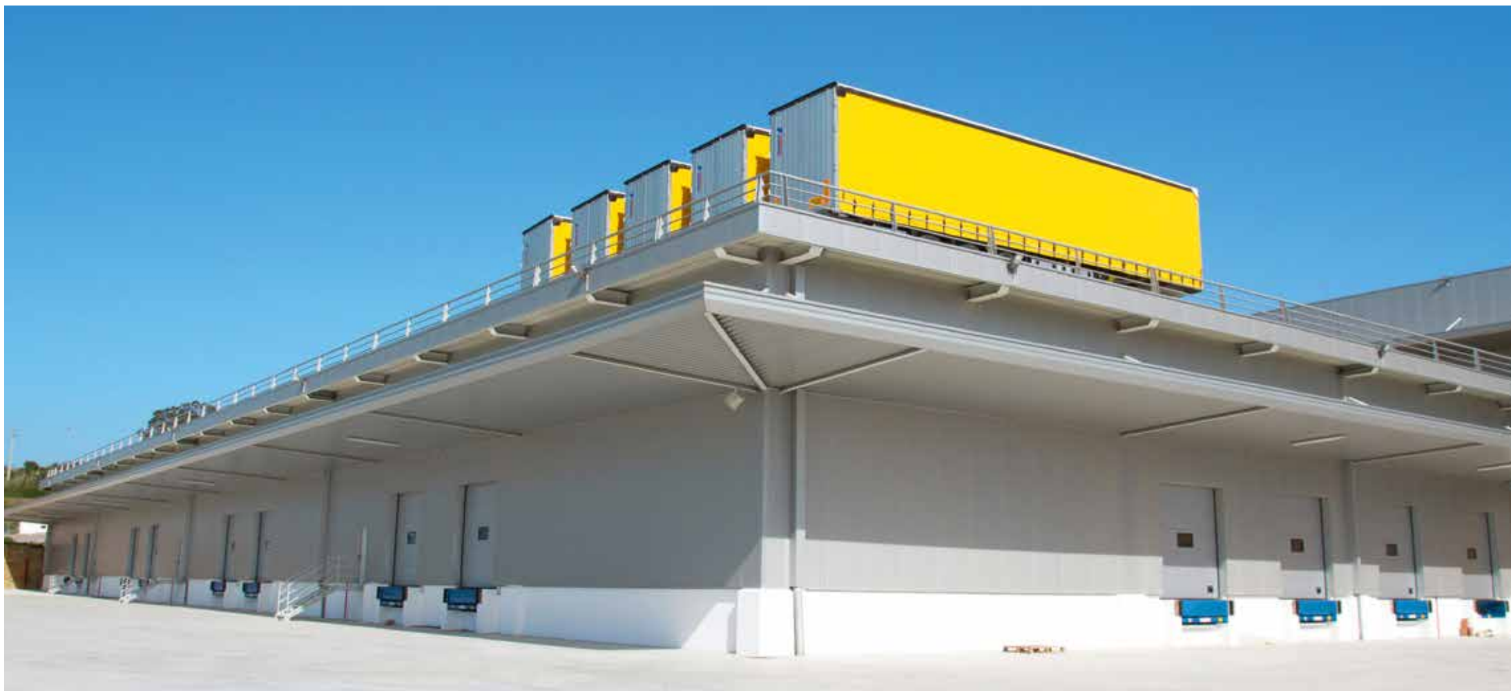
Edifício de apoio a logística - Loures - Portugal
