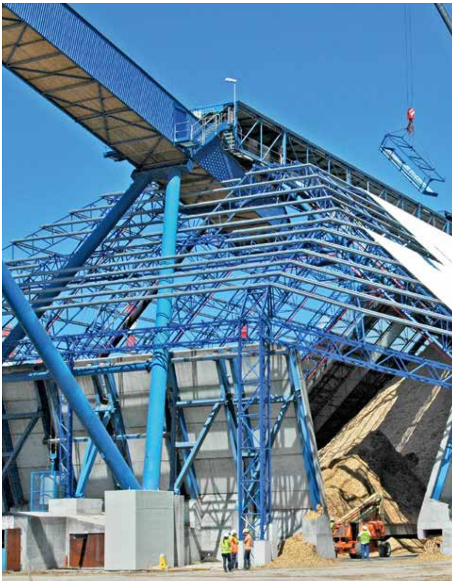
Estrutura metálica e cobertura para armazém de aparas (indústria de produção de papel)
