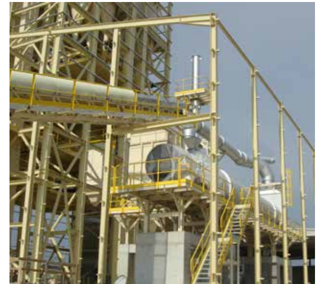
Torre metálica, industria cimenteira - Lisboa - Portugal
