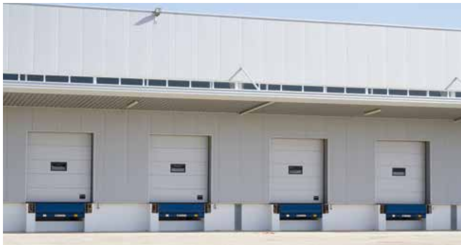
Edifício logístico (Pormenor cais de carga)
