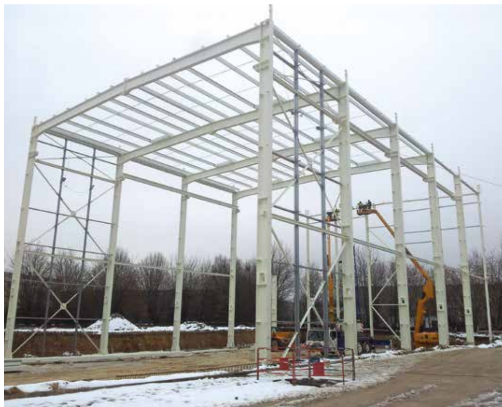
Hangar Metálico - Croissy-Beaubourg, França
